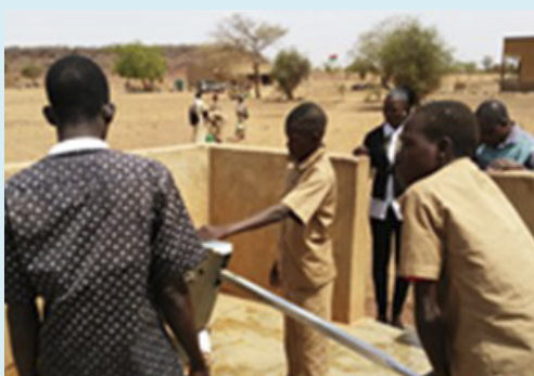
Forage au sein du collège d'enseignement général
