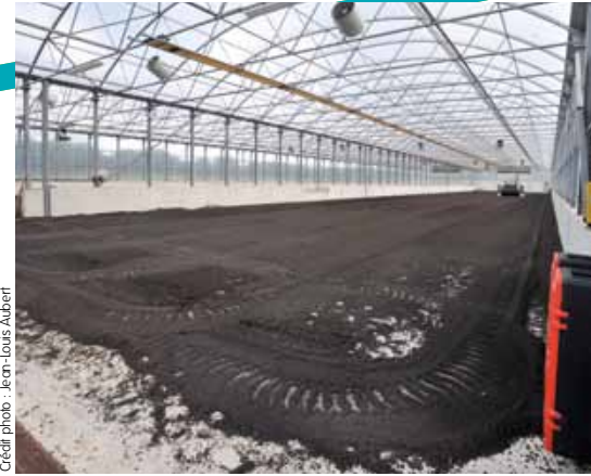
Séchage solaire des boues (Châteaulin, 29)
