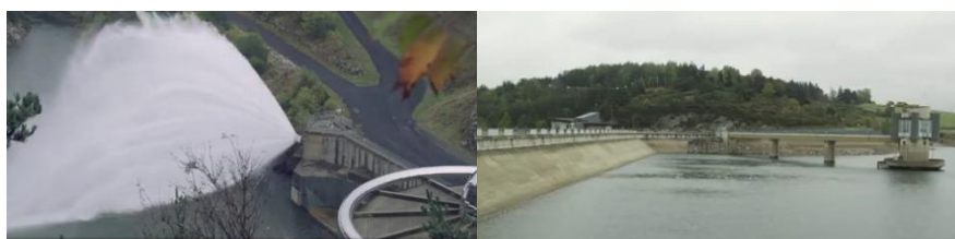
Barrage de Naussac (EPTB Loire) 33 .
