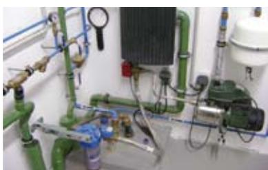
Système de surpression et d'appoint de l'installation de récupération des eaux pluviales
