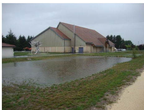
Figure 13 : Bassin d'infiltration de la salle de sports de Commelle Vernay (source : Roannaise de l'eau)
