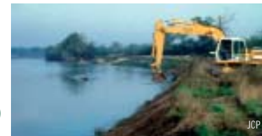
Travail mécanique de la berge (58)
