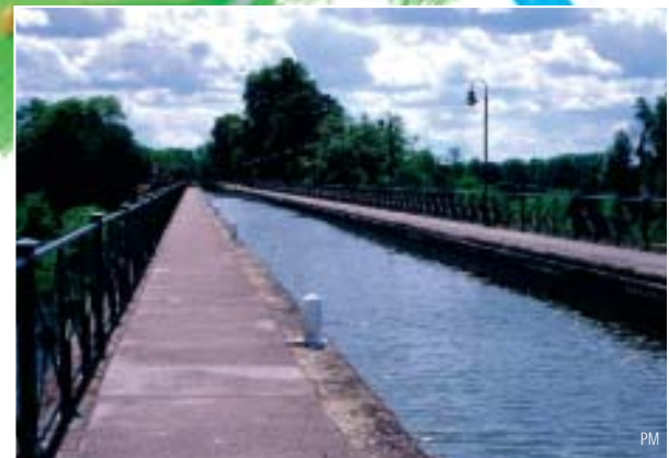
Pont canal de Digoin (71)
