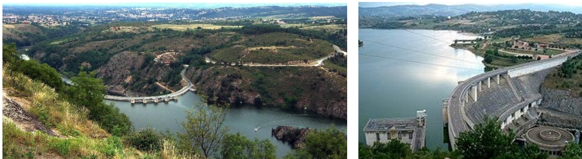
Figure 64 : Barrage de Grangent (Gauche) et de Villerest (Loire) (Droite) Source : EDF France
